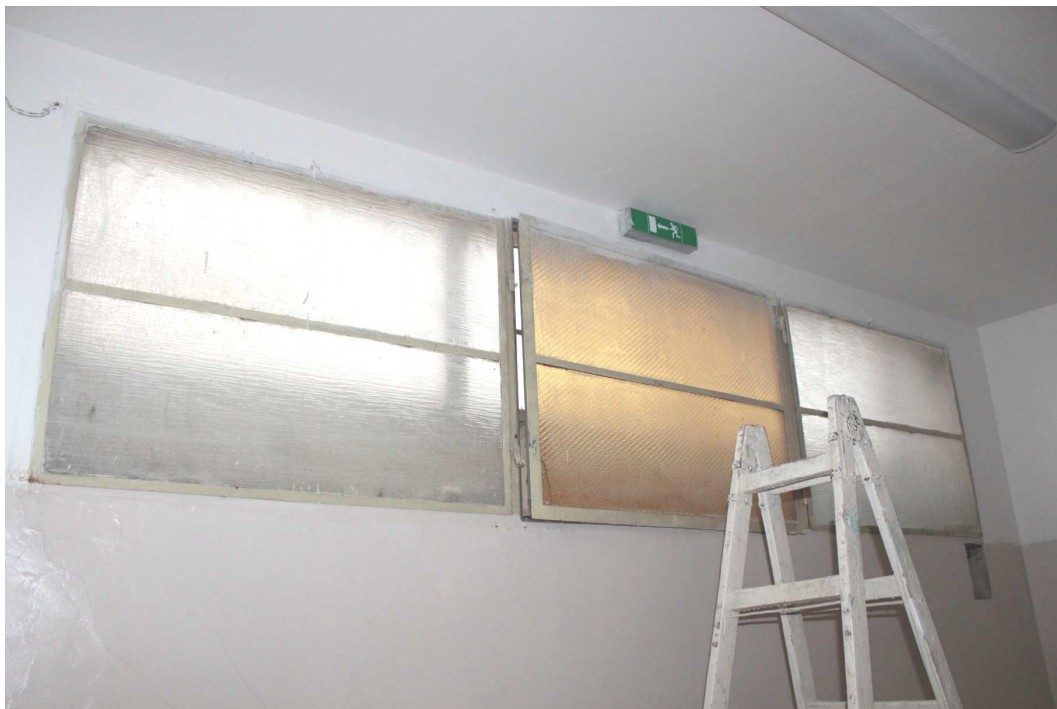
13. Pohled z interiéru na samostatnou část prosklené stěny jižního schodiště v úrovni přízemí na vnitřním líci obvodového zdiva.
