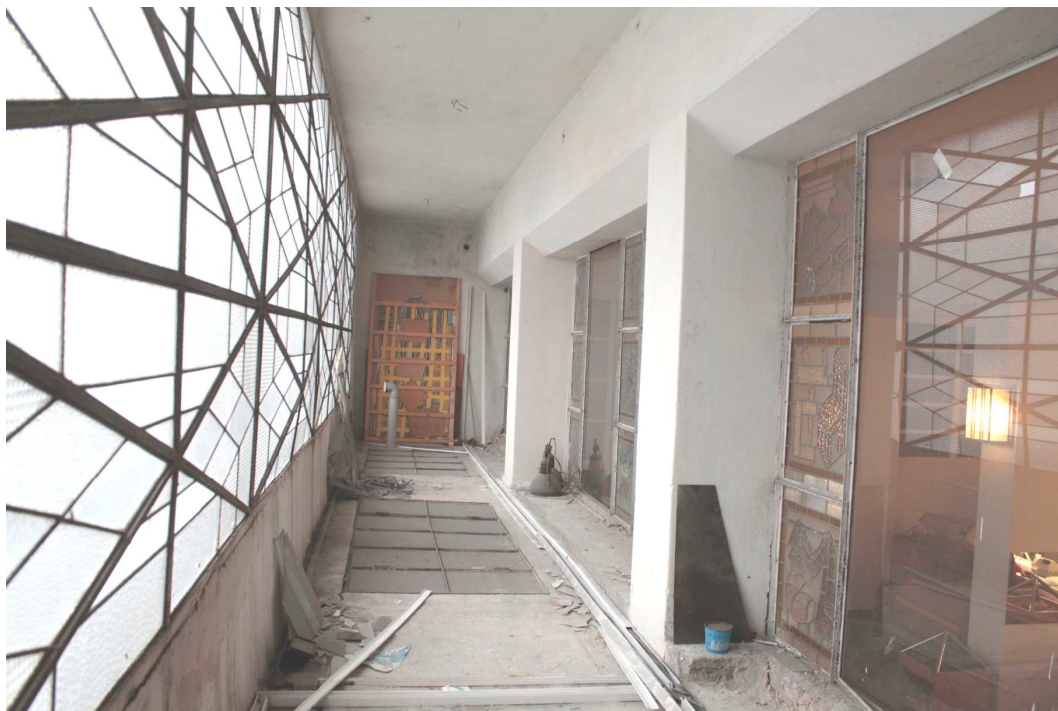
25. Celkový pohled do prostoru nad zádveřím nad bývalým hlavním vstupem do budovy na východním průčelí – vlevo geometrická vitráž na fasádě, vpravo figurální vitráž v interiéru, uprostřed prosklený podhled.
