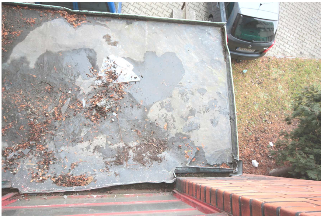
11. Pohled shora na poškozenou střešní krytinu u markýzy nad bočním vchodem na severním průčelí původní budovy pod prosklenou stěnou severního schodiště.
