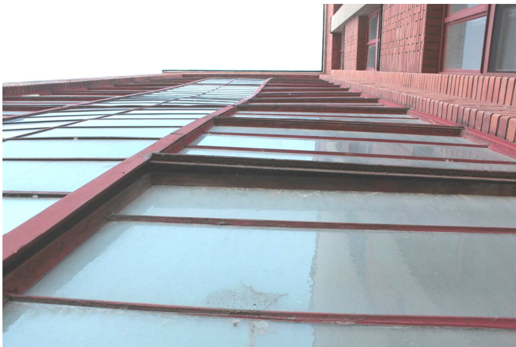
10. Pohled z exteriéru na výraznou deformaci prosklené stěny severního schodiště.
