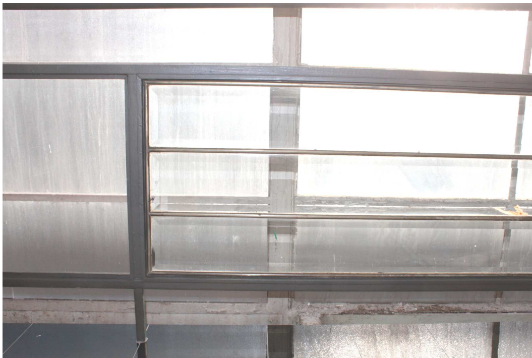
6. Pohled z interiéru na zábradlí u prosklené stěny jižního schodiště, vlevo chybí výplň z fazetového skla, zasklívací rámeček z bílé mosazi a ocelová zasklívací lišta.
