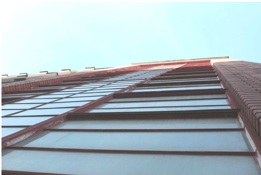
2. Pohled z exteriéru na mírnou deformaci prosklené stěny jižního schodiště.
