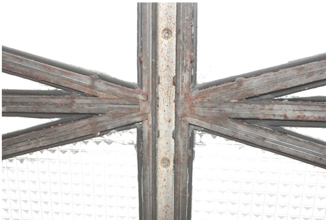
17. Detailní pohled z interiéru na styk plátů u hlavního sloupku nosného rámu geometrické vitráže nad bývalým hlavním vchodem do budovy na východním průčelí.
