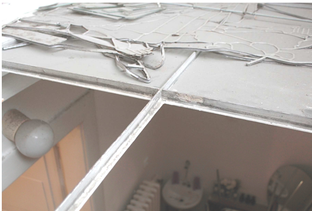
26. Detailní pohled na prosklený podhled v nad zádveřím bývalého hlavního vchodu do budovy na východním průčelí, na podhledu provizorně uložena zdevastovaná figurální vitráž z vnitřní líce zdi.
