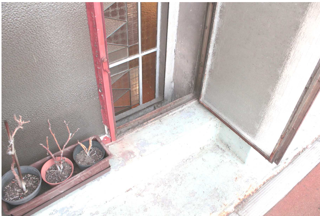
24. Detailní pohled na parapet a vnitřní zasklení geometrickou vitráží u prosklené stěny na terase nad bývalým hlavním vstupem do budovy na východním průčelí.
