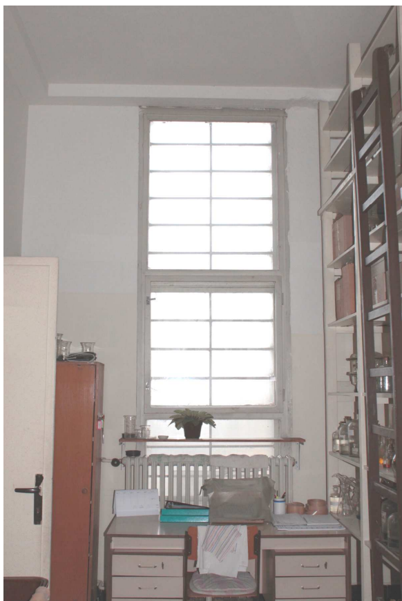
21. Pohled z interiéru na část prosklené stěny vedle bývalého hlavního vstupu do budovy s prosklenou dřevěnou stěnou na vnitřním líci obvodové zdi.
