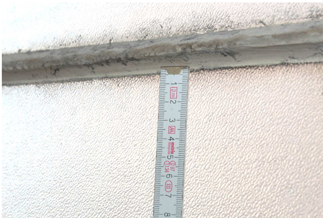
8. Detailní pohled na stávající číré strukturované sklo u prosklené stěny jižního schodiště.
