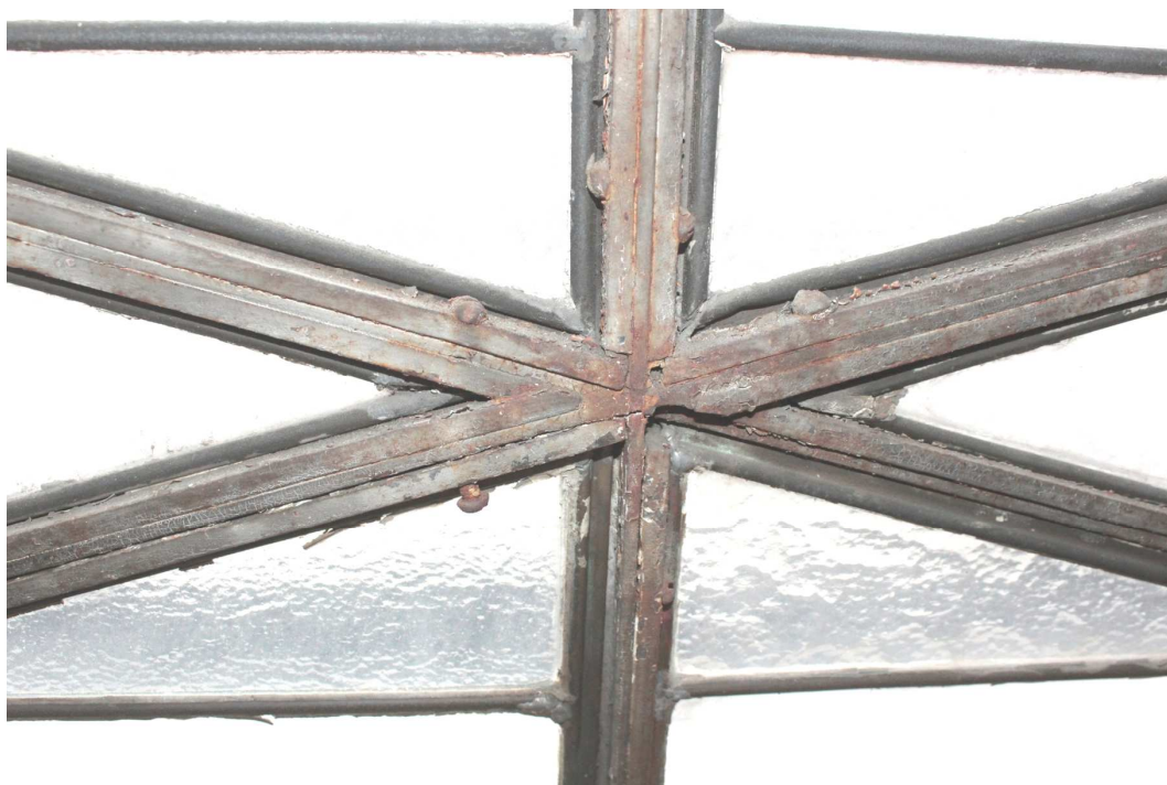
18. Detailní pohled z interiéru na styk plátů u vedlejšího sloupku nosného rámu geometrické vitráže nad bývalým hlavním vchodem do budovy na východním průčelí.
