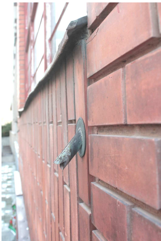
4. Pohled z exteriéru na odvodňovací trubičku napojenou na kondenzační žlábek v interiéru u prosklené stěny jižního schodiště.
